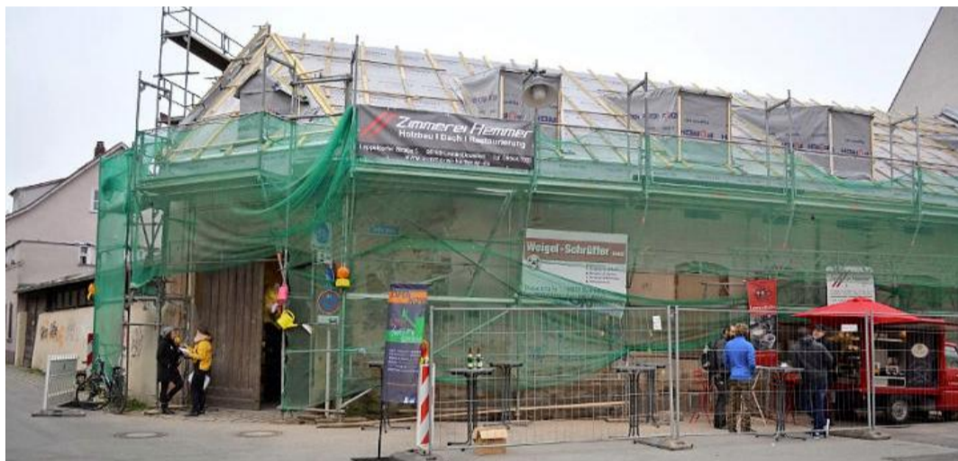
Das Dach steht, die Erwartungen wachsen: Die Kulturgärtnerei soll unter anderem einer Pfadfindergruppe und einem Brauereiverein eine Heimat geben und ein neuer Ort für Veranstaltungen werden. Fotos: Andreas Thamm
